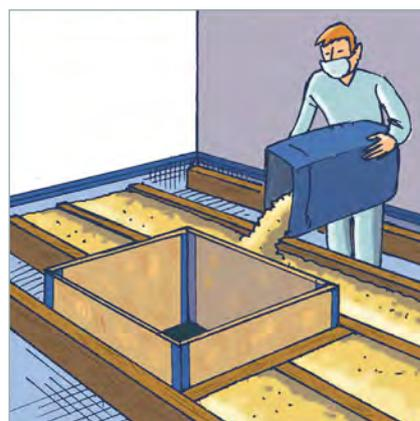
Pose de l'isolant (cellulose en vrac) entre les poutres. Assurez-vous que la trappe d'accès soit également rendue étanche à l'air. Ici, ce sont des panneaux OSB (frein-vapeur) qui ont été utilisés.
