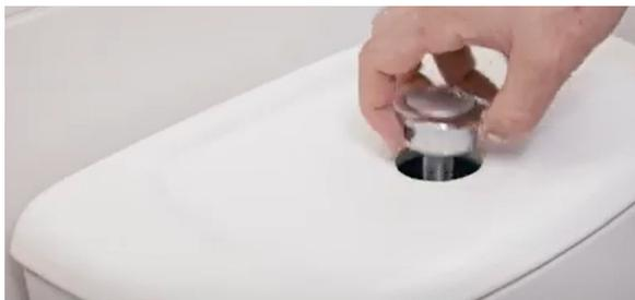
3. Placer le poids sur le flotteur. Lorsque le bouton de chasse d'eau est relâché, le poids ferme le flotteur et la chasse d'eau s'arrête immédiatement (contre force).
