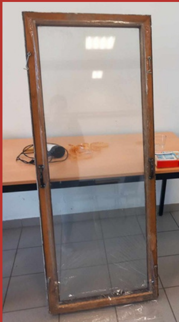
Mise en place survitrage
